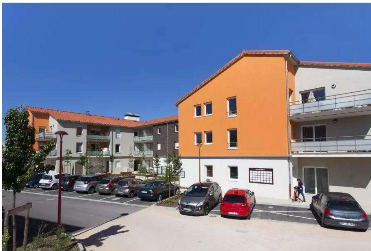
Résidence la Corcy'nelle, rue de la Bergerie.
