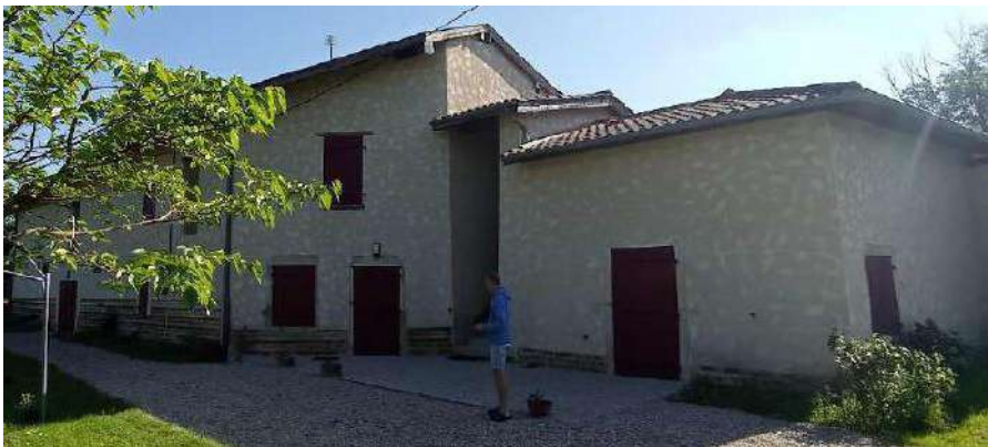
Et dans partie nord du bâtiment 13 :
